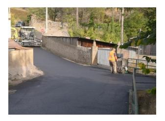
Réalisation d'un enrobé chemin de Clavière qui permet un accès facilité à la déchetterie ainsi que la connexion avec la partie déjà goudronnée (à partir du pont sur le ruisseau du Pouget) de ce même chemin sur la commune voisine d'Apchat. Le montant de ce chantier est de 47717 € H.T.
